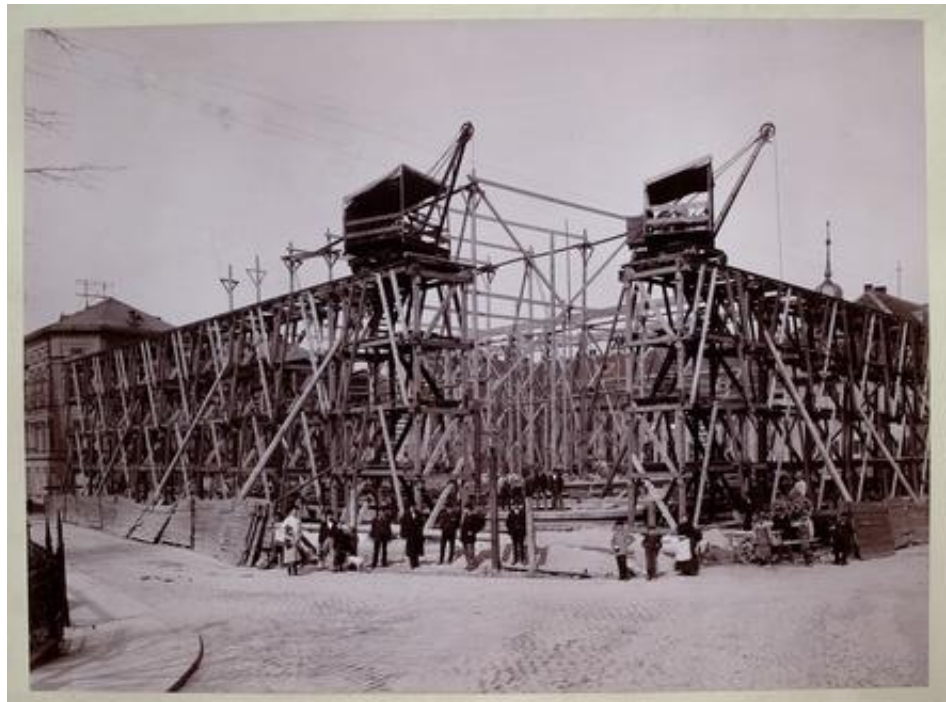
Bild: Bau der Universitätsbibliothek, Baustelle, https://www.deutsche-digitale-bibliothek.de/item/Z4DNGDOGVD5DCJ6ZJJ2FAG5DF7FY2WK
